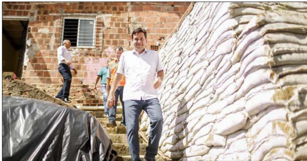
Serão realizadas 350 obras do tipo no Recife. Desse total, 77 já estão em andamento
